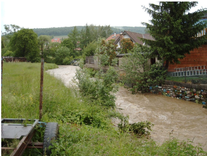
Direkte Einleitung von Regenwasserkanälen unterstützen das rasche Ansteigen der Bäche
